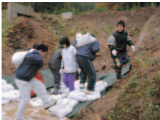
▲砂をつめた土のうを積み上げました
