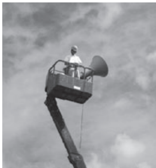
防災行政無線の現地調査
