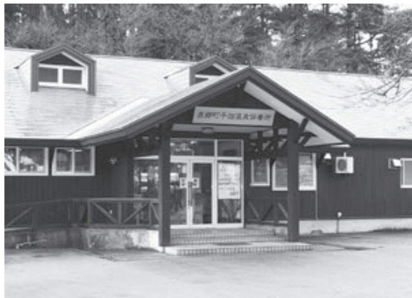
解体される千畑温泉保養所
