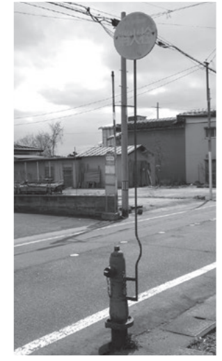
防火水道管更新 (六郷中央地区の 消火栓)
