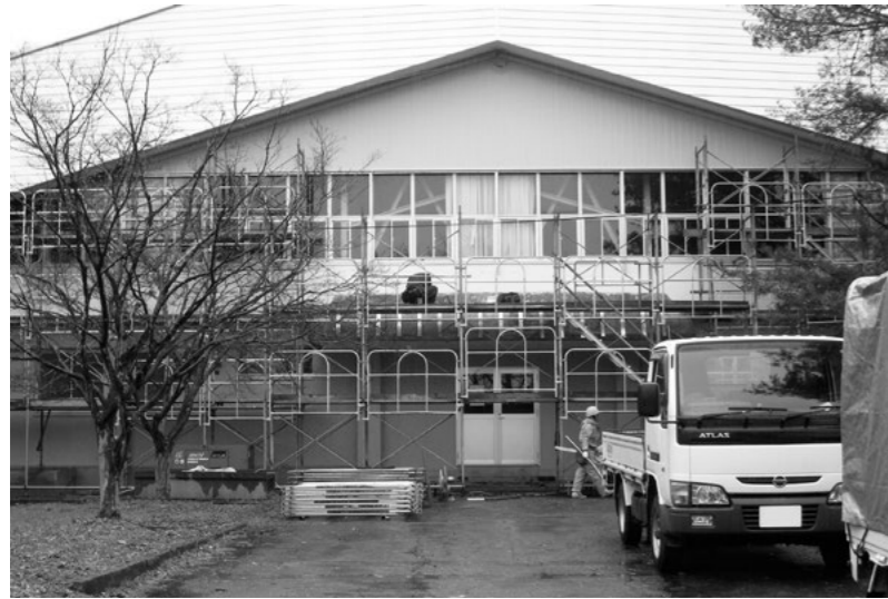
改修工事中の北体育館(現在は完了)
