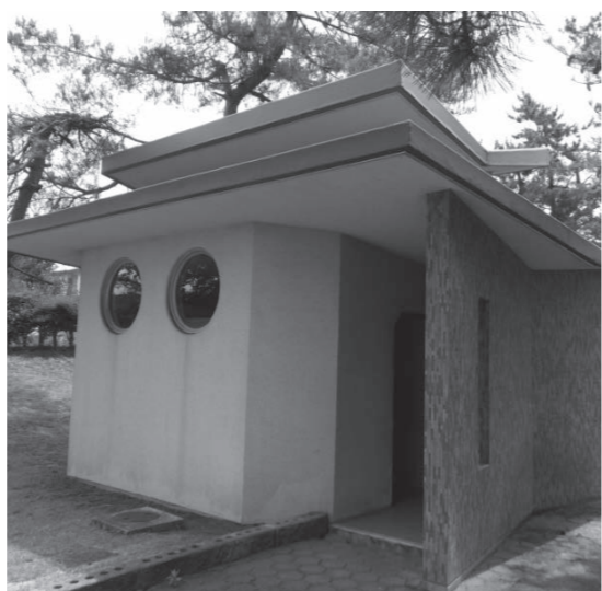
水洗化される中央公園トイレ
