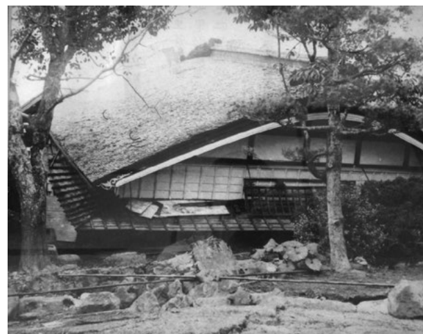
明治29年陸羽地震の建物被害(坂本東嶽邸)
