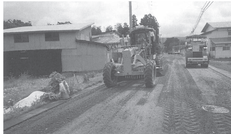
快適実感プロジェクト(道路舗装工事)
