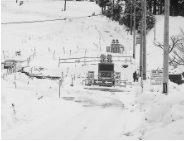
工事中の大坂橋付近
