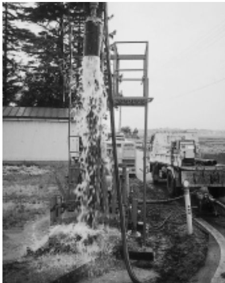
水源調査の様子
