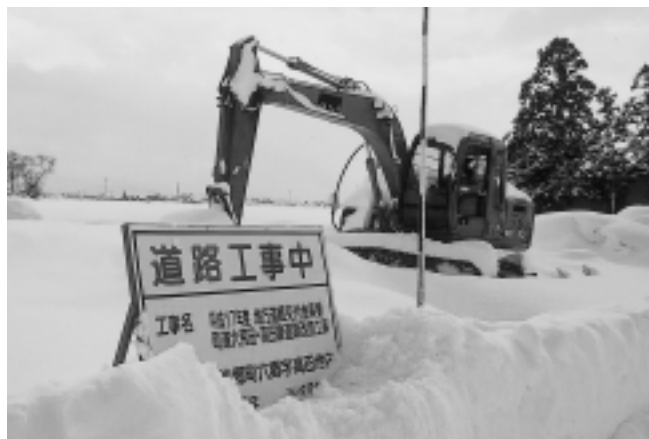
今年の大雪に埋もれた工事現場
