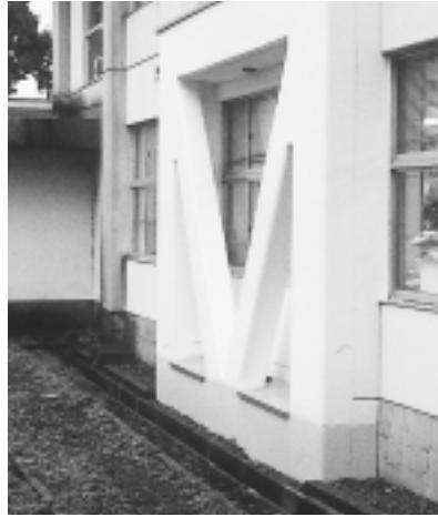
補強工事を行った六郷中学校
