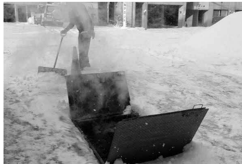
融雪槽を使った除雪作業
