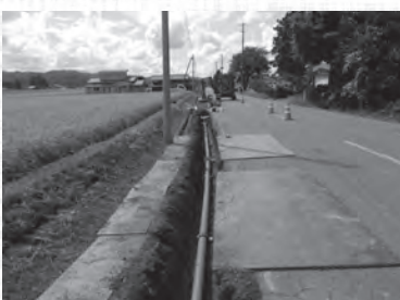
配水用ポリエチレン管を使用
